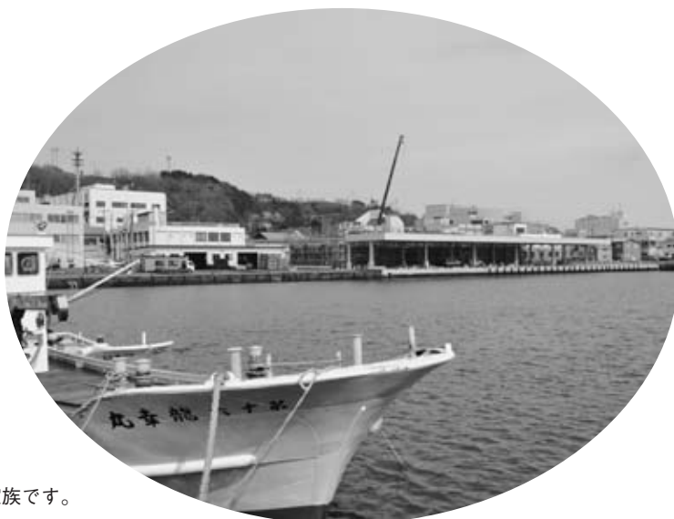
荷捌き所新築中の浦河の港
