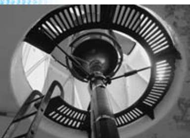
灯台の要「電球」を下から見たところ 間隔の開いた板が電球を囲んでいます
