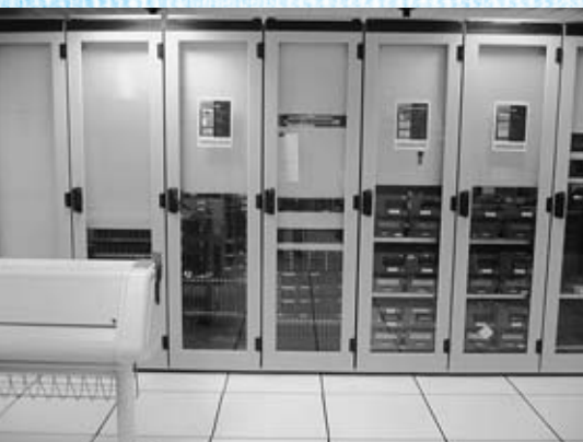
データ処理装置は、ストリーマケーブルで受信した信号を処理して、3次元表示が可能なデータにします
