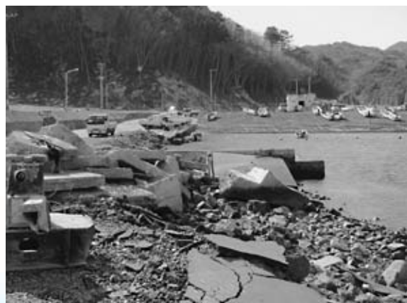
早期の岸壁の復旧が望まれる音部地区の港
