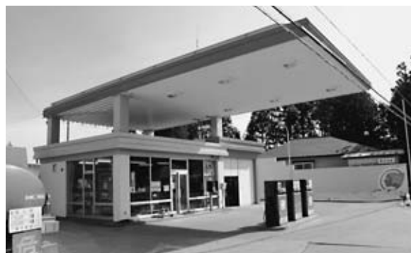
漁協で唯一残った倉庫(写真上)と ガソリンスタンド(写真下)は初期の被災生活を支えました
