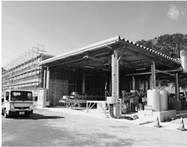
3月上旬に稼働開始予定のワカメ加工施設
