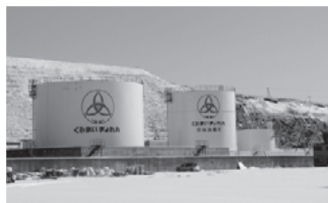
ぎょれん花咲油槽所は根室管内の燃油需要を一手に引き受けています
