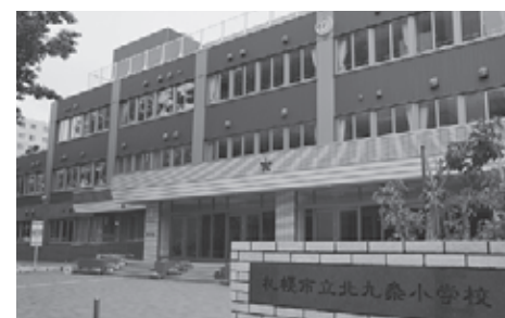
最新の省エネ設備を誇る北九条小学校
