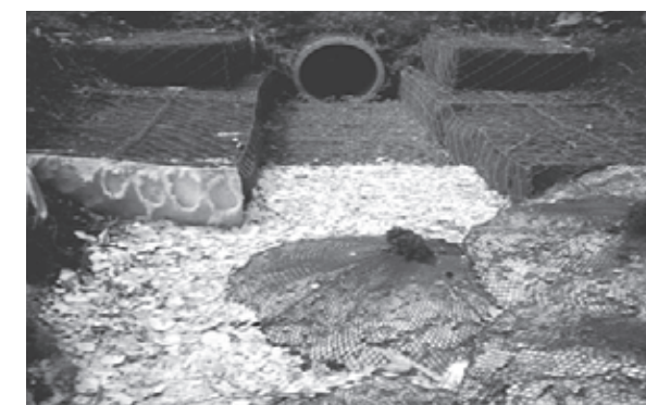
ほたての焼成貝殻の排水溝口への設置
