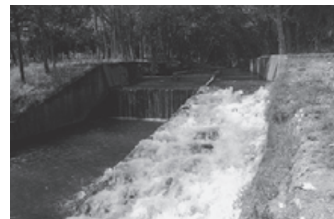
落差のある河川に設置された魚道（標津町 ウラップ川）
