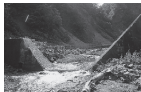
スリット化したダム（標津町 イケショマナイ川）
