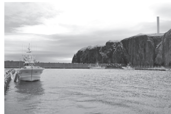
落石漁港昆布盛地区は30mを越える断崖に隣接している
