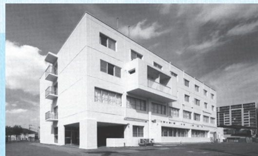
千葉県柏市に建つ校舎全景
