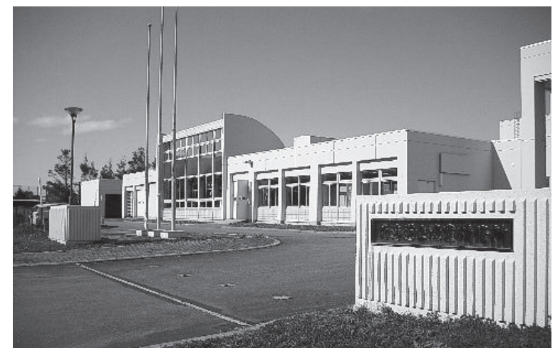
・研修棟 施設として講義管理棟、漁業実習棟、潜水・機関管理棟、体育館他からなる
