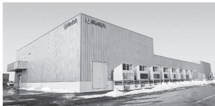
完成した稚内新工場は、設計・監理をぎよれんマリノサポート(株)が担当。ほたての貝剥き処理台やトンネルフリーザー、自動計量包装機など備えています
